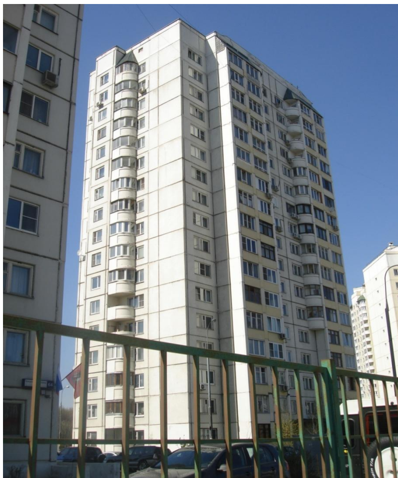
Рис.3. Первый энергоэффективный дом в Москве на улице Академика Анохина, 62, на тепловых насосах (2001год). (Фото Сваловой В.Б.)
