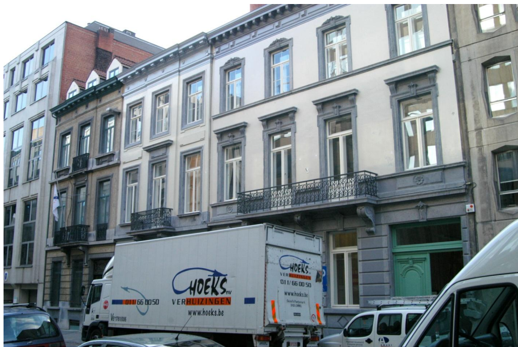
Рис. 6. «Дом возобновляемой энергии» в Брюсселе, Бельгия. (Фото В. Сваловой).
