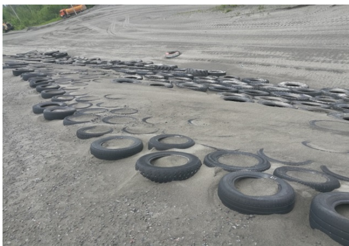
Рис. 2. Автомобильные покрышки, уложенные на участке хвостохранилища
