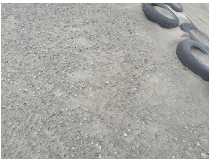
Рис. 3. Щебень, уложенный на поверхности сухих хвостов
